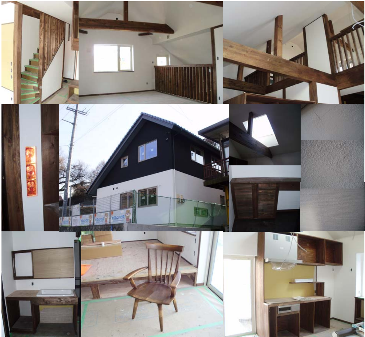
※写真は実際の建物の1月3日現在の工事中の風景です。
